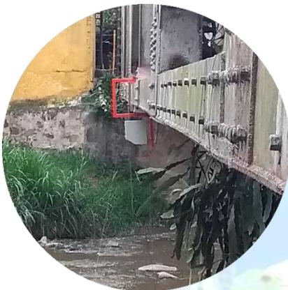
Estación Hidroclimatológica de niveles Bocas, se encuentra ubicada en el municipio de Girón. Hace parte de la Red Hidroclimatológica de la CDMB. Permite el registro de las variaciones en los niveles de columna de agua para esta sección del río. La estación Bocas tiene sensor de para medir velocidad y con ello calcula el caudal.
